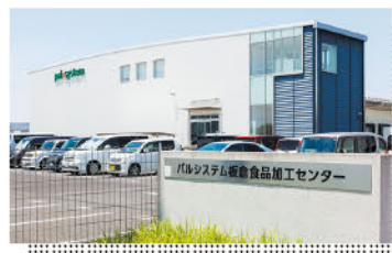
パルシステム板倉食品加工センター (群馬県 板倉町) 2017年9月開設
